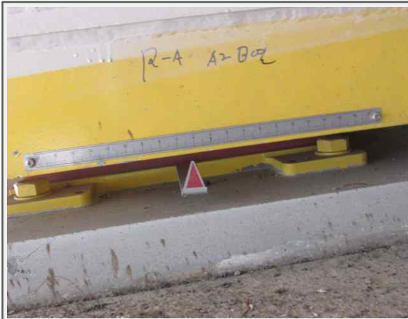
A2 교량받침 이동량 측정
