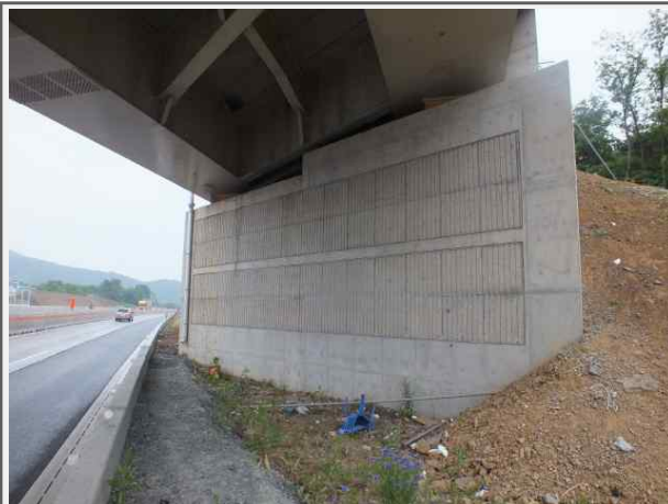
내 용 영천JCT Ramp-A교 교대
