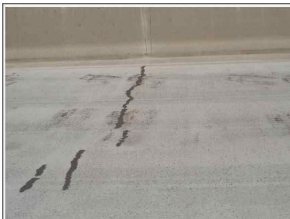
내 용 콘크리트 포장 균열보수
