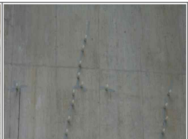
내 용 수지주입 균열보수
