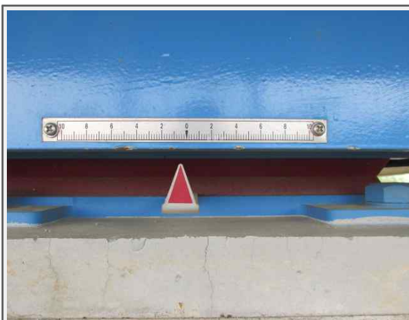
P12 교량받침 이동량 측정
