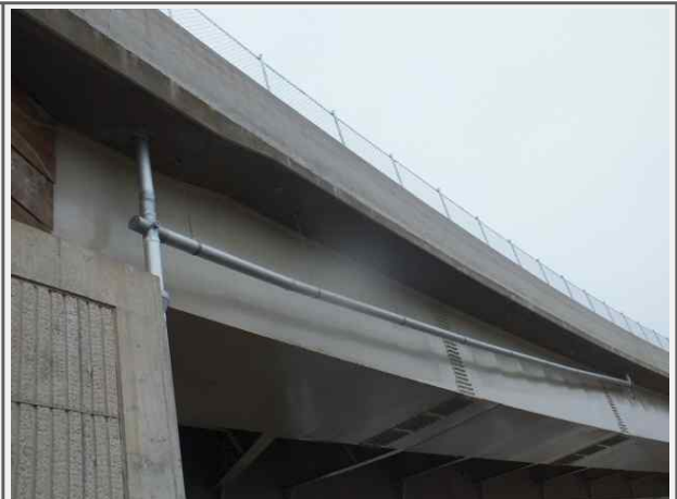
내 용 영천JCT Ramp-A교 배수관
