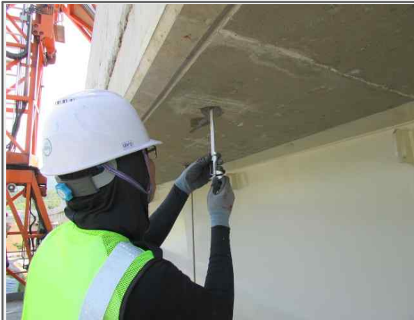
상부구조 탄산화깊이 측정
