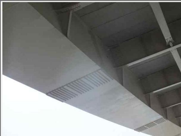
내 용 영천JCT Ramp-A교 거더
