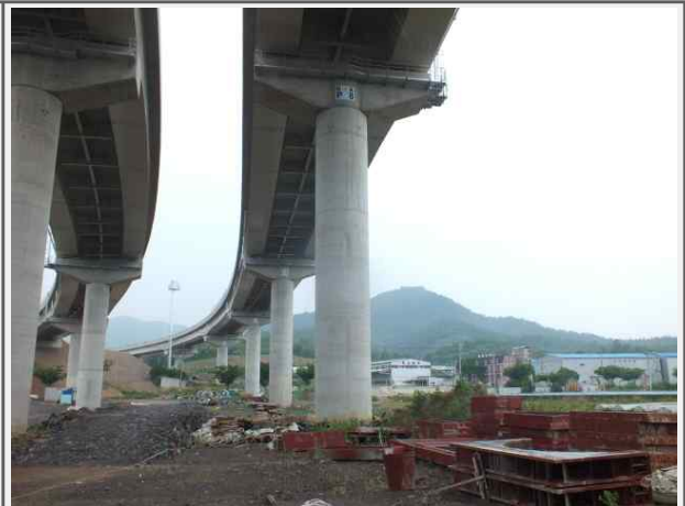
내 용 영천JCT Ramp-A교 교각
