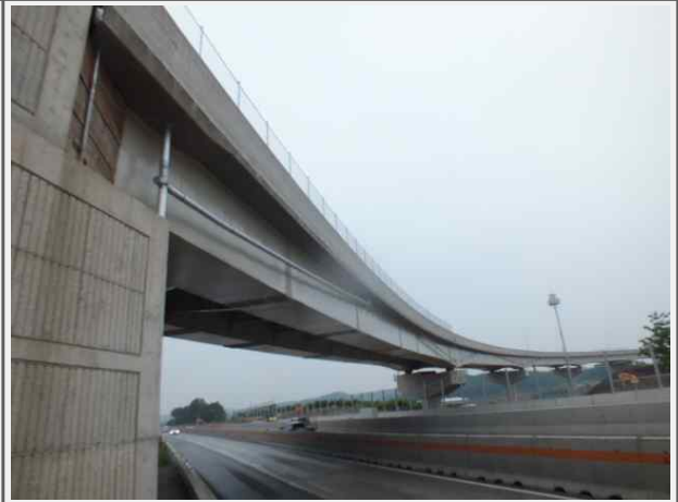
내 용 영천JCT Ramp-A교 측면
