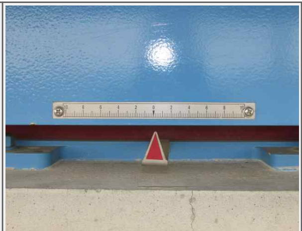
P10 교량받침 이동량 측정
