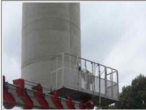
내 용 교각 기둥부 균열보수 현황
