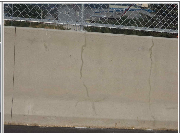
내 용 방호벽 균열보수
