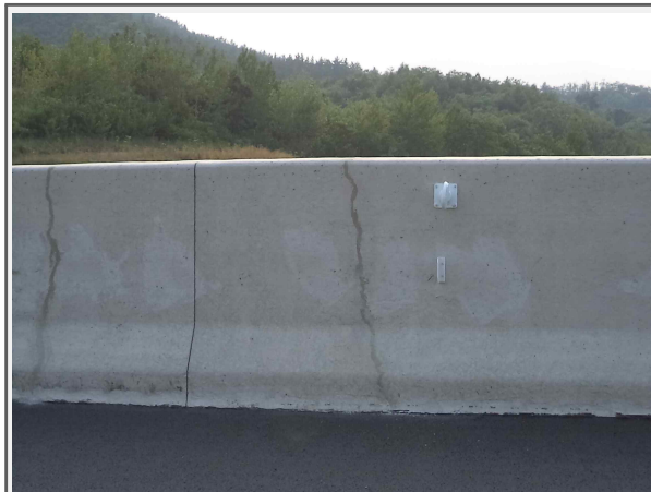
내 용 방호벽 균열보수
