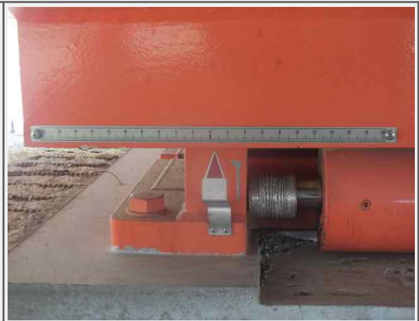
P8 교량받침 이동량 측정
