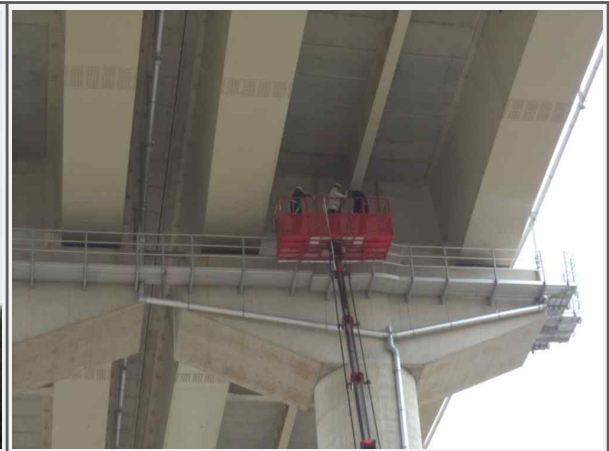
내 용 교각 코핑부 균열보수 현황
