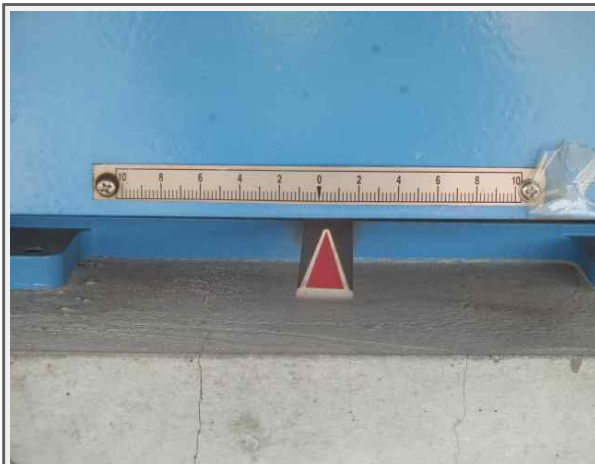
P9 교량받침 이동량 측정
