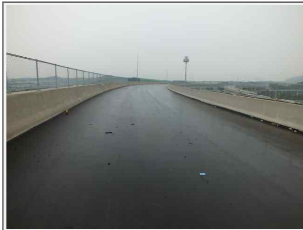
내 용 영천JCT Ramp-A교 상부
