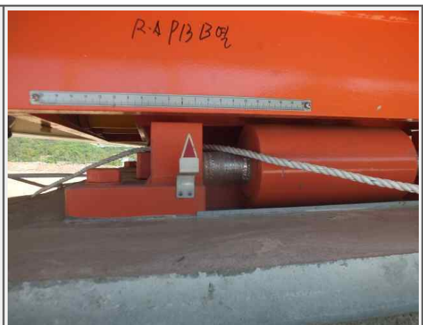
P13 교량받침 이동량 측정
