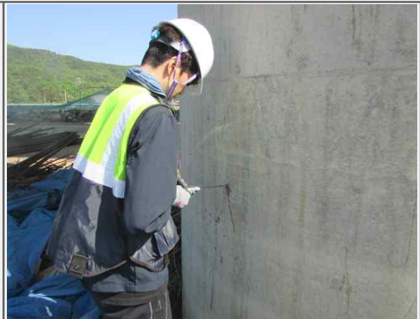
하부구조 탄산화깊이 측정
