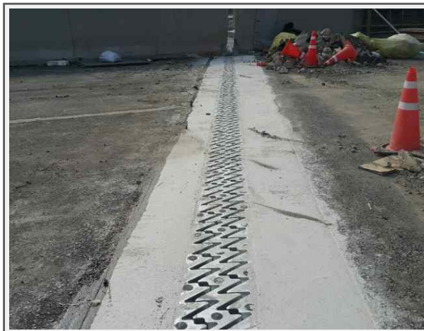
영천JCT Ramp-A교 A2-NO.200 (FINGER JOINT)
